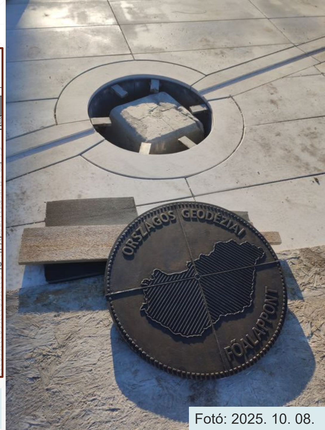
100×100 cm-es vasbeton akna, felette 60 cm átmérőjű körgyűrűs acéllemez nyaktag, tetején öntött bronz koronggal, felirattal
